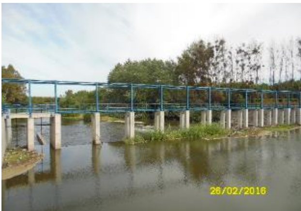
Bocatoma Uva Blanca (Captación Canal Nilahue Tramo I)
