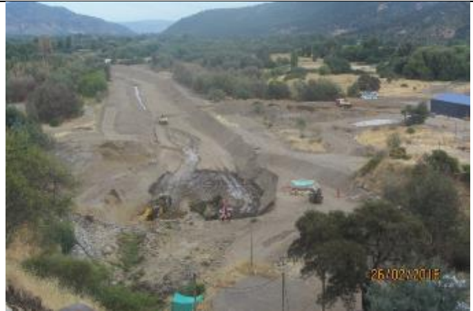
Trabajos de excavación de las fundaciones de la Casa de Máquinas con excavadoras Link Belt 210 y Komatsu PC 200. Al lado derecho se aprecia la fundación de la Grúa Torre y la Instalación de Faenas. El Canal de Restitución y al fondo el Puente San Luis.
