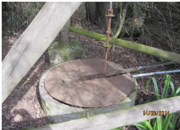
Pozo de agua, incorporada en la red de estaciones de Calicatas, ubicada en el sector de Santa María del Porvenir
