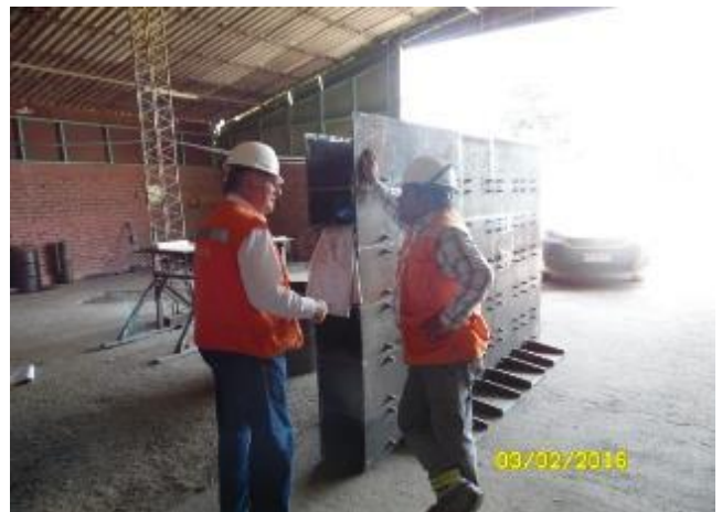
Compuerta Modular Metálica Desarmable N° 1, armada.
